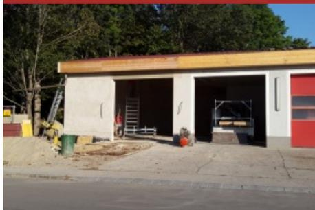
Der Unterbau für die Vorplatzerweiterung ist vorbereitet. Zur Aufnahme des Dachwassers wurde ein großzügig dimensionierter Sickerschacht hergestellt. Betonpflaster und Beleuchtung werden noch folgen.
