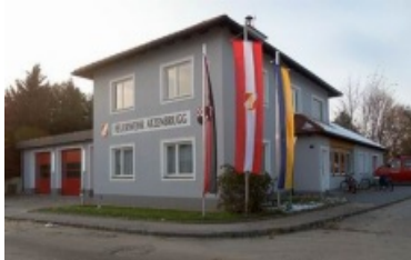
2003: Umbau und Erweiterung Feuerwehrhaus
